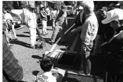
《消火栓の内部と操作手順の確認》
